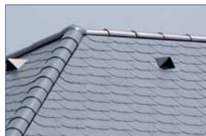
Velikost výstupního otvoru větrací hlavice je 100 \text{ cm}^2/1 \text{ ks} .
