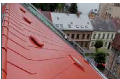
Větrání střešního pláště je realizováno plastovými hlavici.
