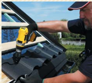
Kotvení startovací lišty
