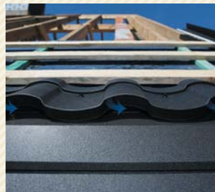
Kotvení startovací lišty
