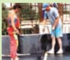
Svařování asfaltových pásů na tepelné izolaci z EPS.
