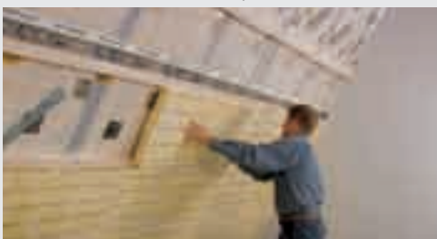
Izolace šikmých střech - mezi krokvemi a pod krokvemi
