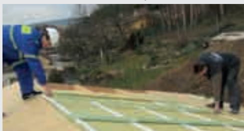
Izolace šikmých střech - nadkroevní systém
